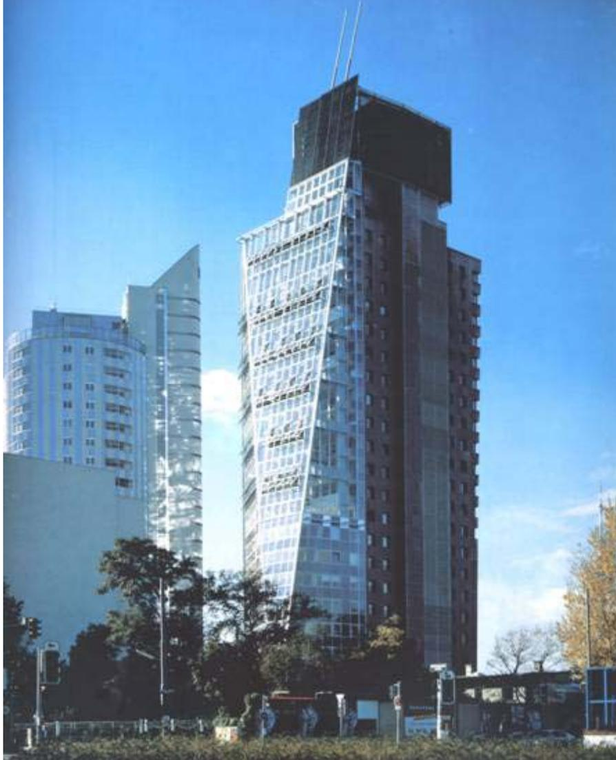
fachada envidraçada "inteligente" juntamente com a ventilação da cobertura e núcleo de circulação(acúmulo de calor) regula a temperatura internamente nos apartamentos
