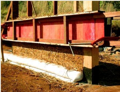
Taipa leve sendo fabricada. Fonte: IPEC.
