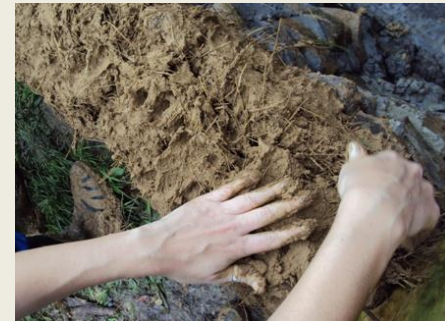
Cob – paredes de barro, moldadas à mão, sem aglomerantes industriais ou formas. Fonte: Arcaverde.
