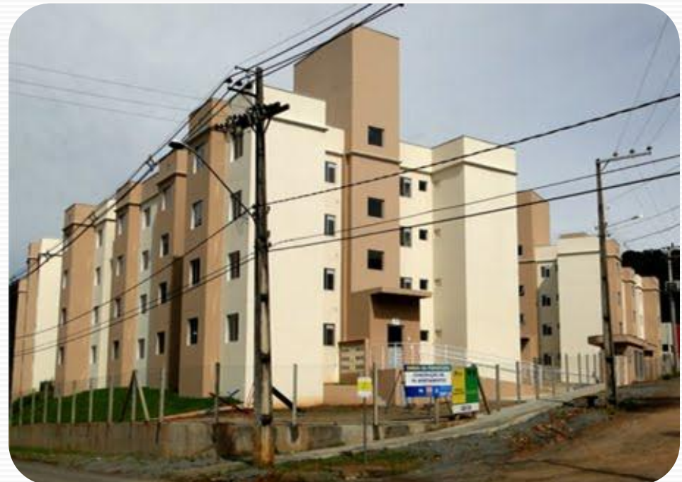
vistas externa do conjunto habitacional Parque Paraíso imagens acervo da autora
