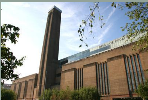
Imagem 03: Tate Modern. Antiga central elétrica de Bankside, Londres.
