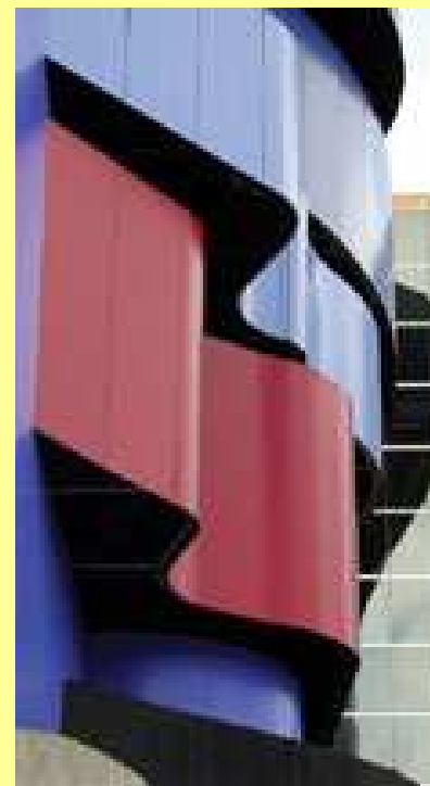
Fig. 29 – Revestimento em alumínio
