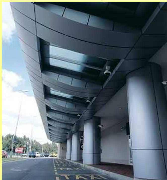
Fig. 28 – Revestimento em alumínio
