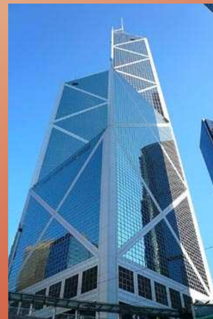
Fig. 33 – Torre do Banco da China; Foto: Alastair McAlpine
