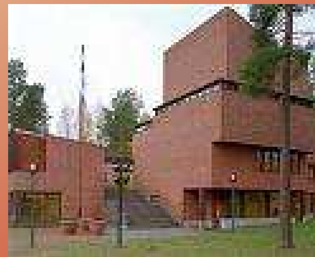
Fig. 11 – Centro Municipal de Säynätsalo, Fachada Oeste
