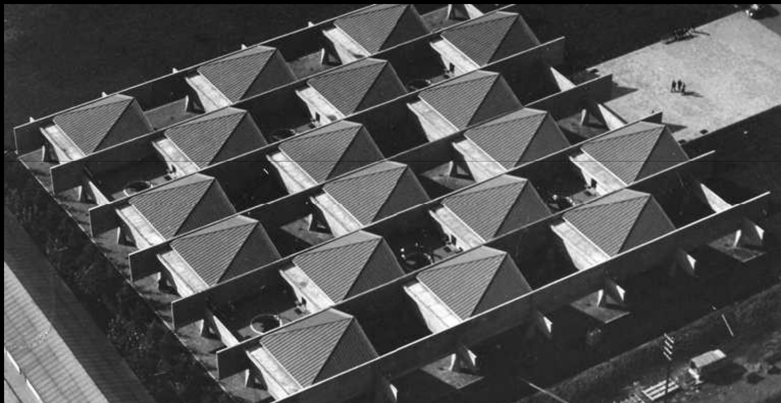
FIG. 072 - VISTA DA COBERTURA DO PRÉDIO DAS OFICINAS
