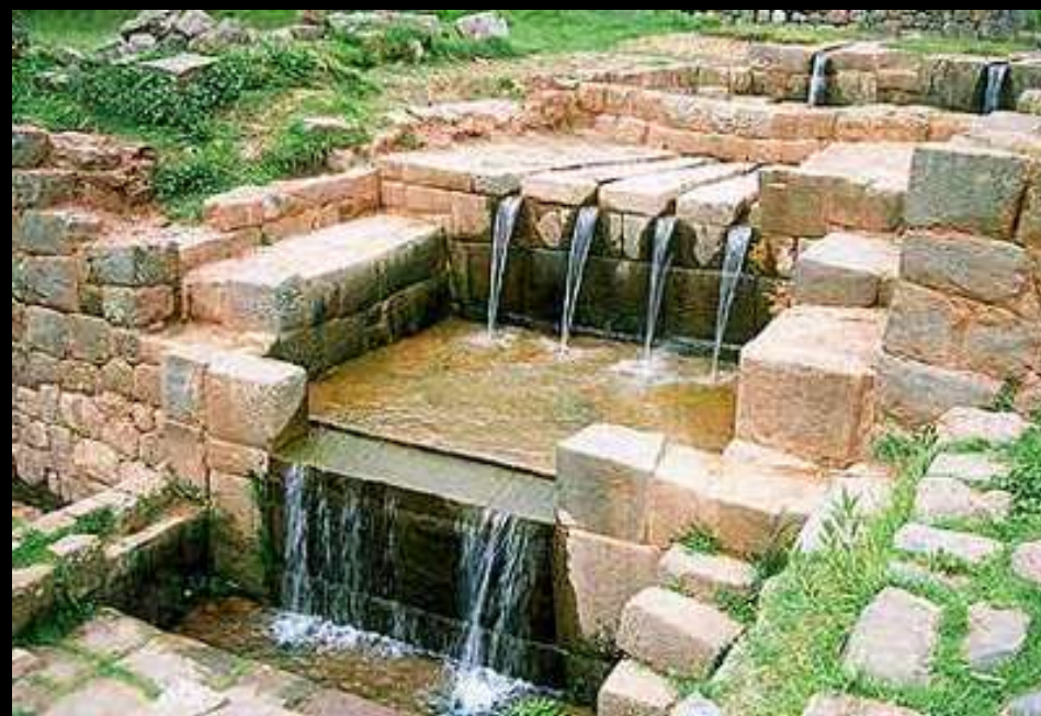
FIG. 036: FONTE DE DISTRIBUIÇÃO DE ÁGUA
