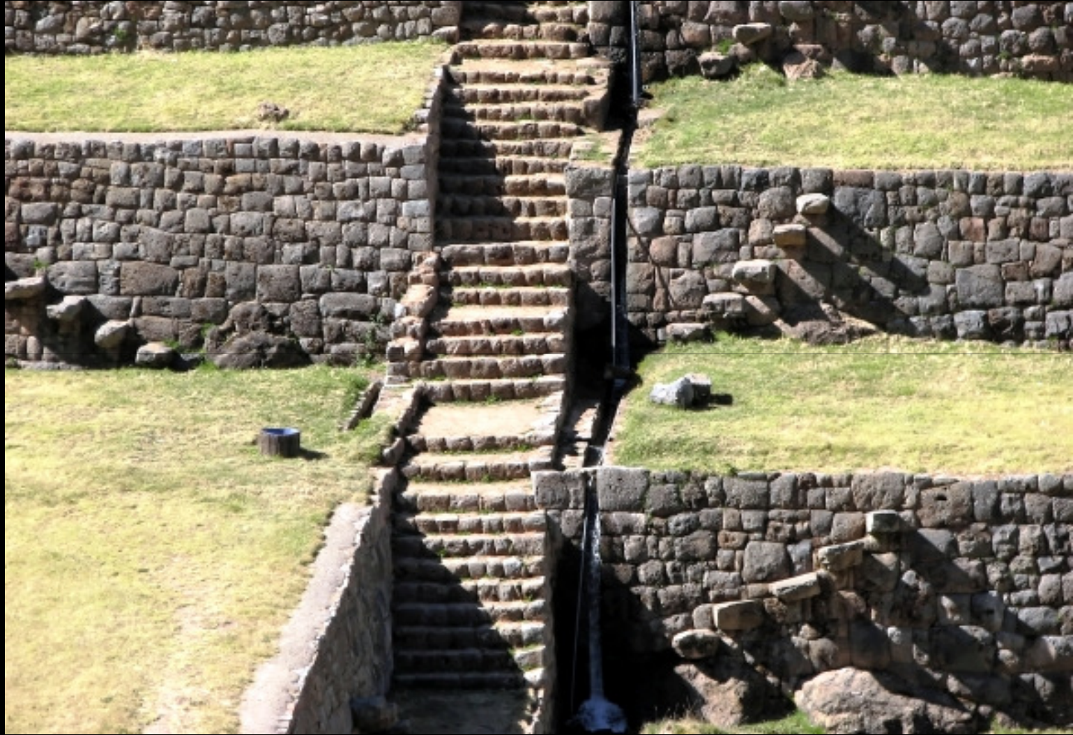
FIG. 037: BEBEDOUROS E ESCADAS CONSTRUÍDAS
