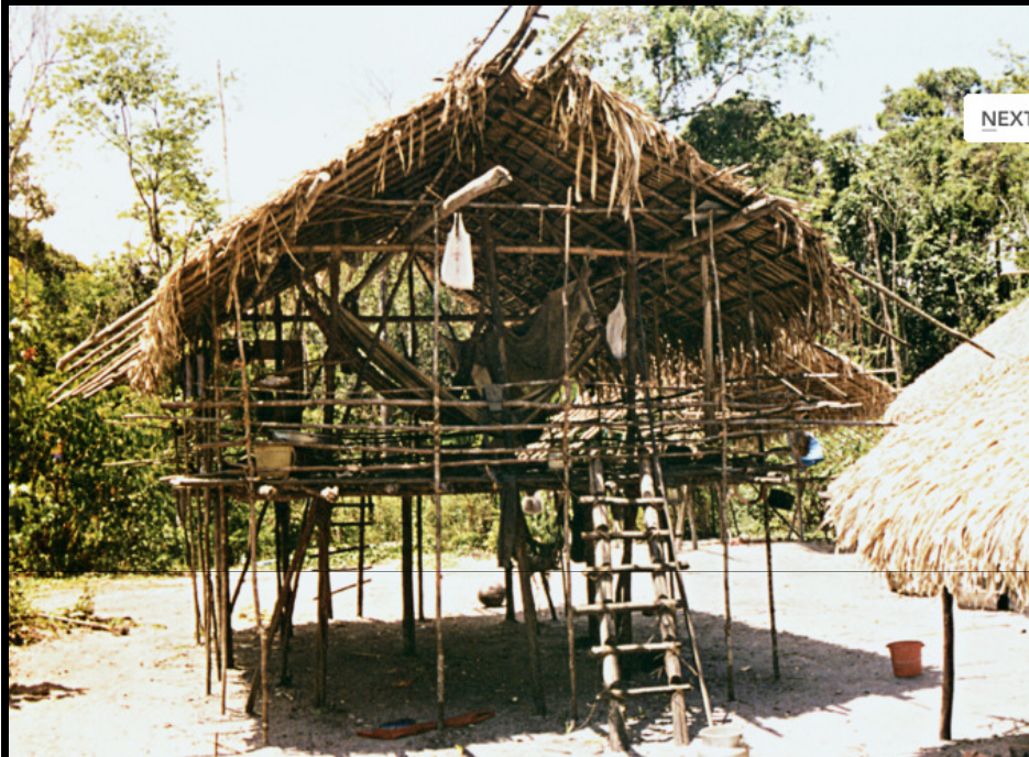
FIG. 047: CASA DE JURA DE SISIWA, COM COBERTURA DE PALHA PRETA.
