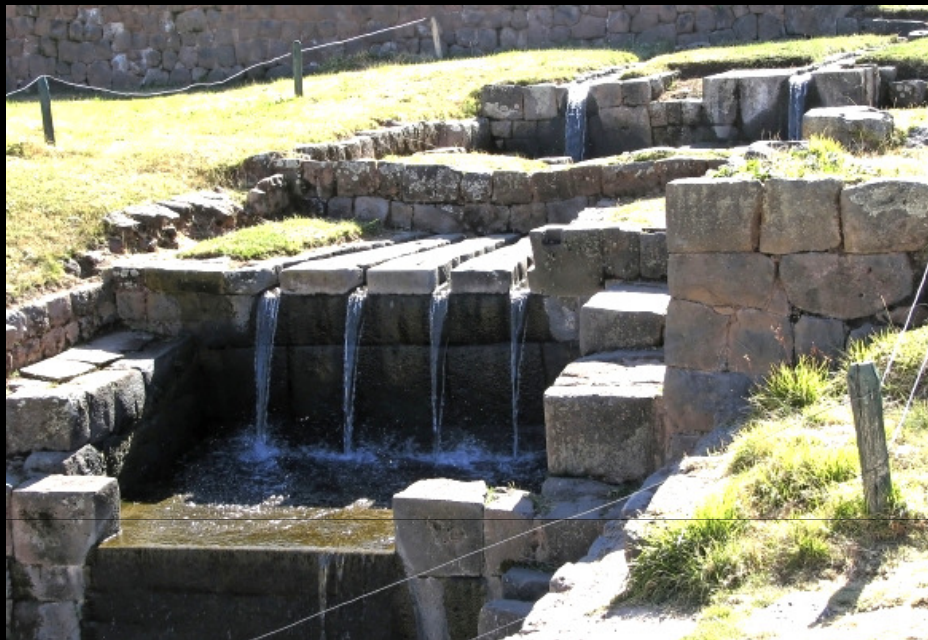
FIG. 035: FONTE DE DISTRIBUIÇÃO DE ÁGUA
