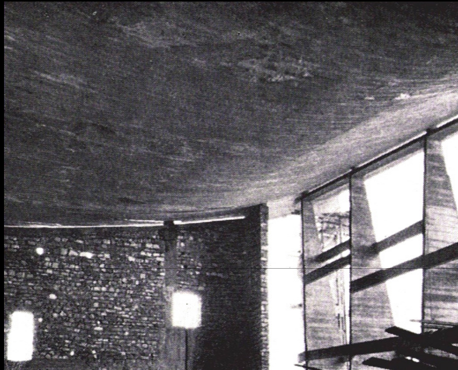
Fig. 060: Interior de uma parte da fachada sul
