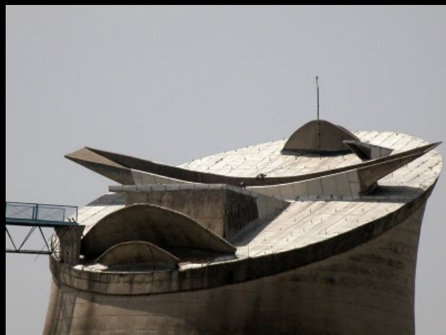
Fig. 033: Detalhe da cobertura do Palácio da Assembléia.
