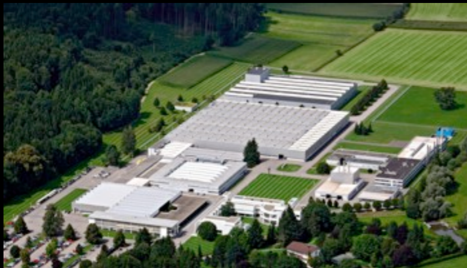
fig. 13: Vista aérea da fábrica Weishaupt GmbH - Schwendi, Alemanha
