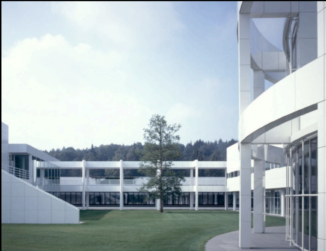
fig. 17: Vista do pátio interno (foto: Scott Frances / ESTO)
