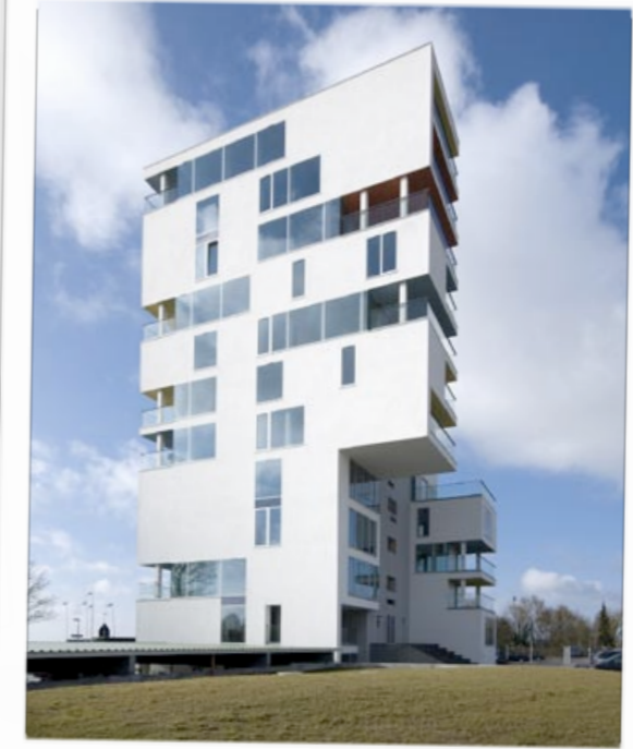
Imagem 5. Edifício residencial do escritório CF Moller, sediado em Copenhague, 2010.
