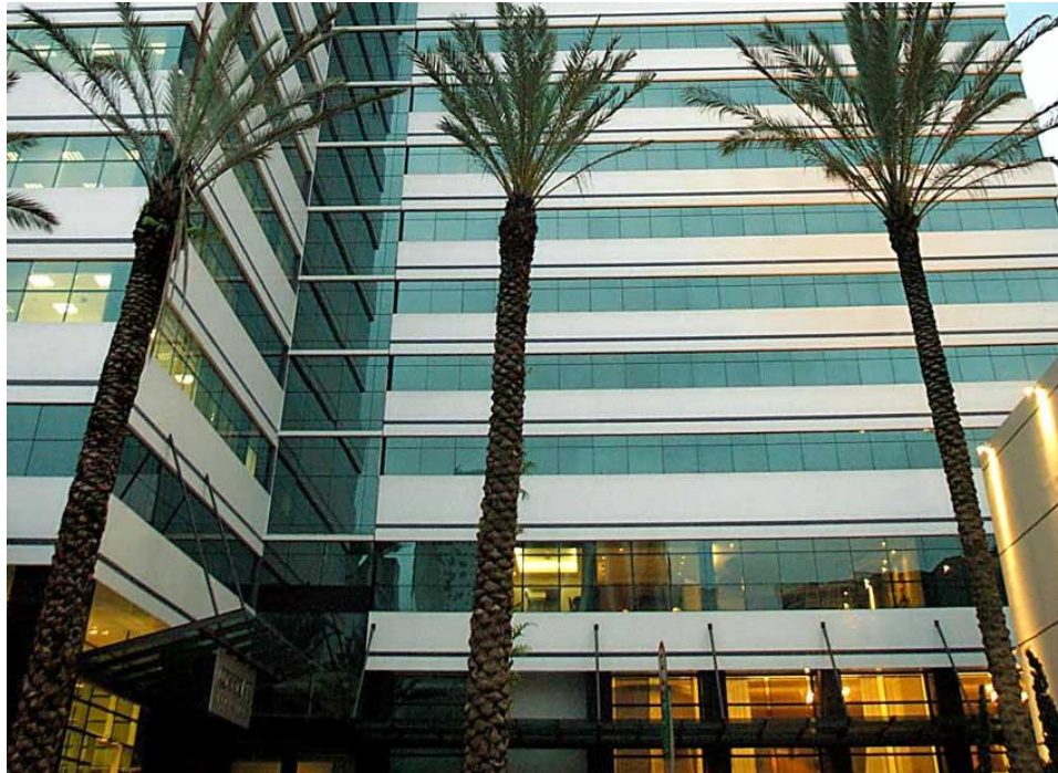
Figura 01: Fachada Hotel Pestana
