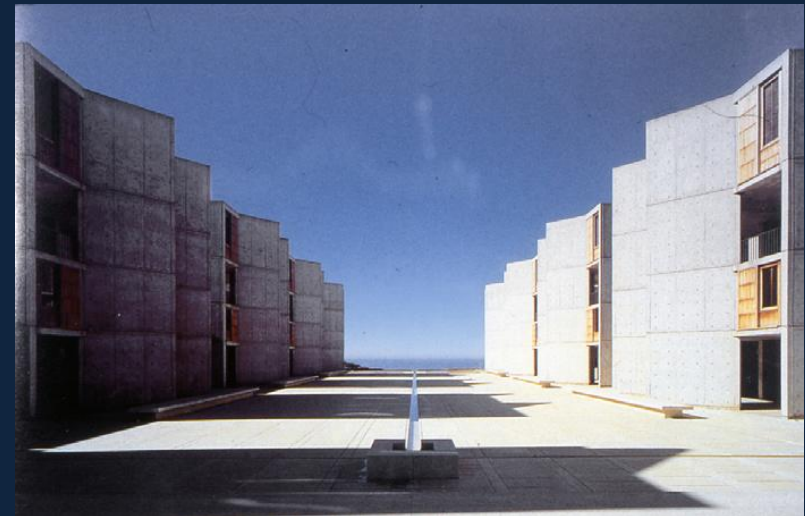
Figura 67: Vista do pátio interno Laboratórios Salk 1959-1965, La Jolla, Califórnia, EUA Arquiteto Louis Kahn
