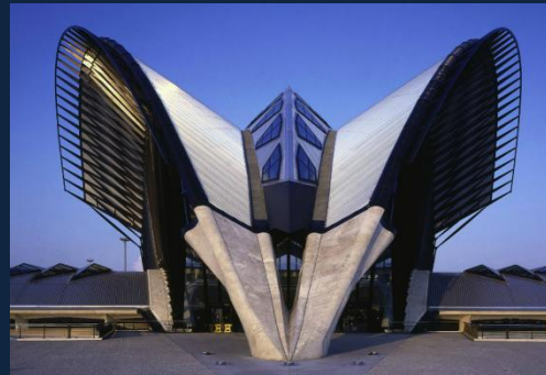
Figura 55: Estação Ferroviária do Aeroporto de Lyon-Satolas, 1989-1994 Lion, França Arquiteto Santiago Calatrava
