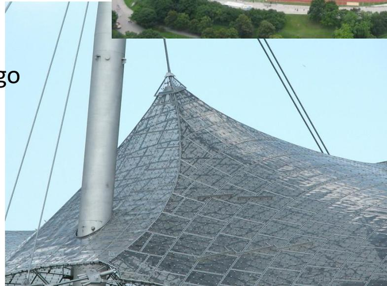
Fig. 126 e 127: Estádio Olímpico de Munique e detalhe da sua estrutura, Arq. Frei Otto (1968 -1972), executado no sistema estrutural tensoestrutura, utiliza-se de painéis acrílicos transparentes, com juntas de neoprene.
