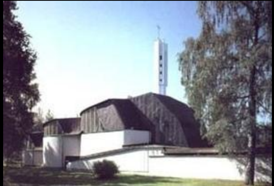
Figura 71 Igreja de Vuoksenniska, Imatra, Finlândia, 1956/59. Vista exterior.
