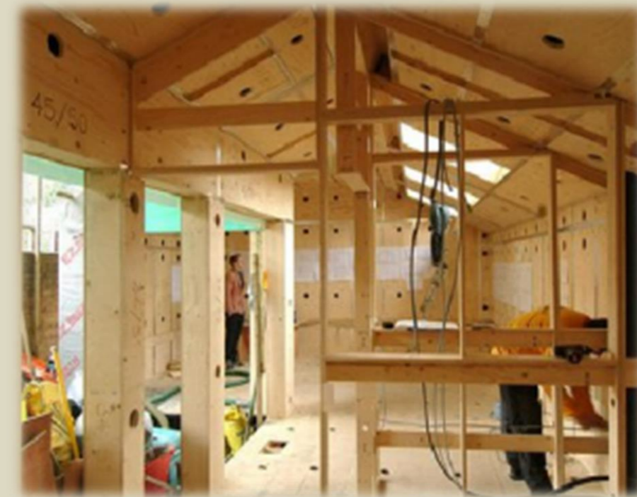
Figura 81 e 82: Produção de Residências por CNC
