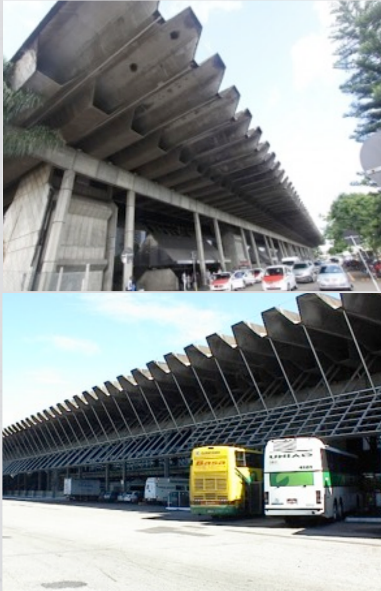
Fig. 02 e 03 - Terminal Rodoviário Rita Maria. Florianópolis - SC. 1976-1981. Projeto e Consultoria de Obra.
