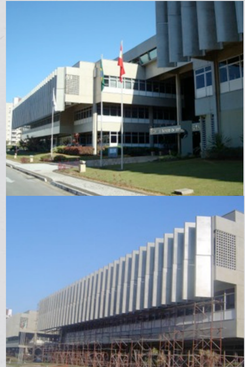
Fig. 04 e 05 - Sede CELESC. Florianópolis - SC. 1985-1991. Projeto e Consultoria de Obra.
