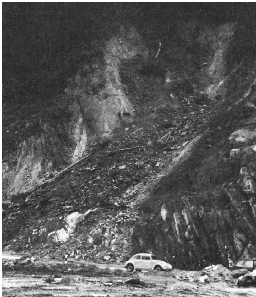
Escorregamento em taludes de corte em rodovias – Fonte IPT
