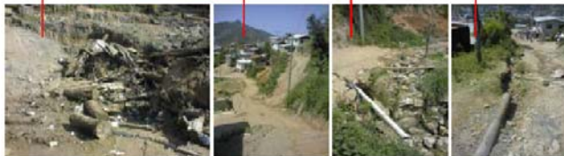
Fotos 2,3 e 4 - Entulho, lixo depositado, escapamento de águas servidas e solo exposto refletem o grau de miséria e desorganização da comunidade
