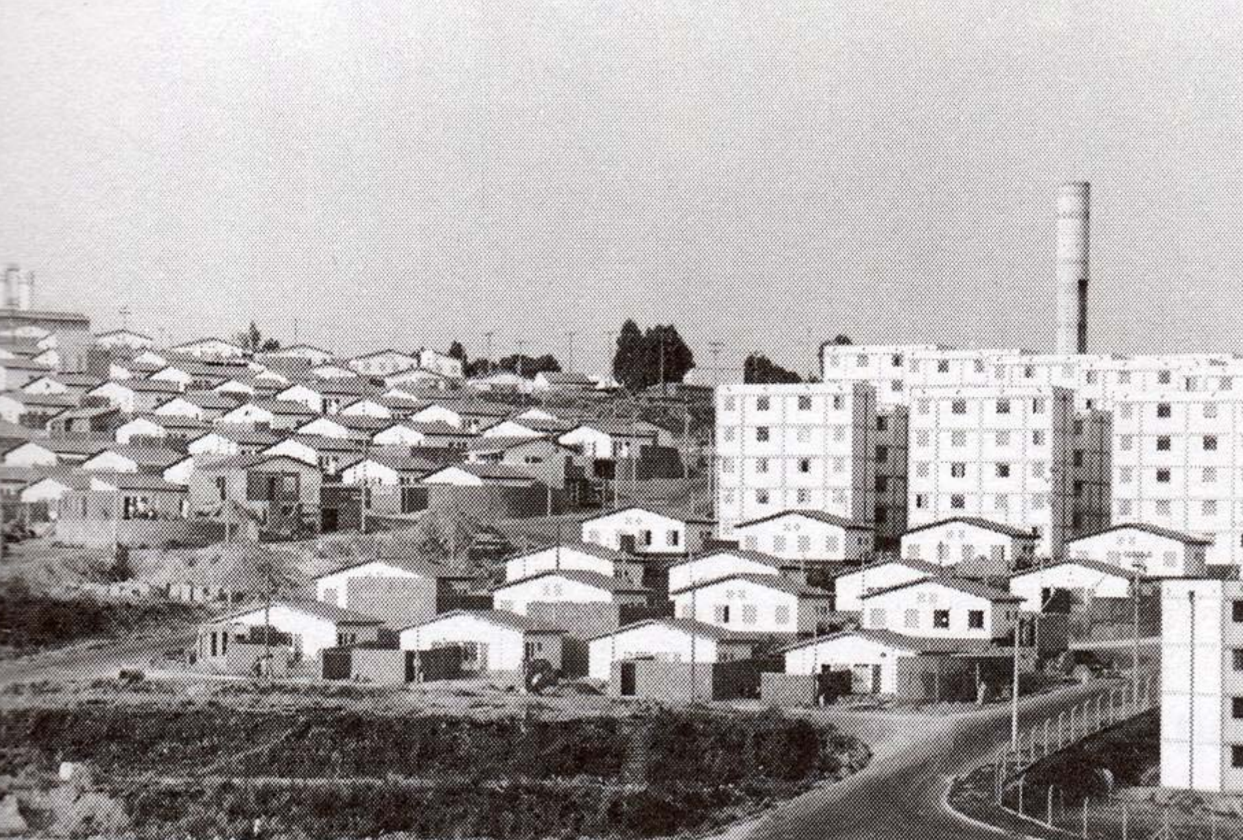
Proj. de conj. Habitacionais limitados pelas exigências legais, seguiram um padrão que se repete em todo o país, com pequenas variações. Foto Conj. Habit. de Vila União - Campinas
