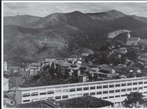
Figura 29: Vista Posterior. Fonte: IPHAN, apud COMAS, 2002.
