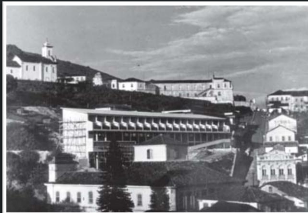
Figura 30: Vista Frontal. Fonte: IPHAN, apud COMAS, 2002.
