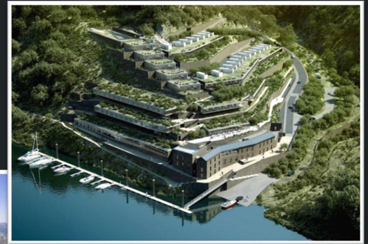
Figura 13: Vista Superior do Complexo. Fonte: JVC
