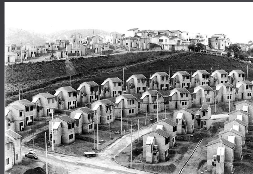
Figura 4: Vista do conjunto de sobrados da CDHU em Santo André –(SP). Desnível acentuado pela movimentação de terra, decorrente da implantação de um projeto convencional.
