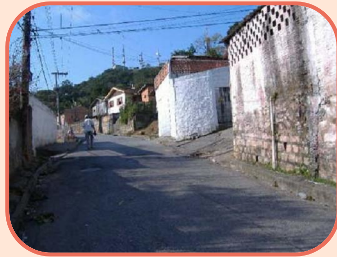
Figura 24: Imagem de uma das ruas da comunidade. Destaque para a falta de calçada para pedestre. Fonte: Prefeitura Municipal de Florianópolis.
