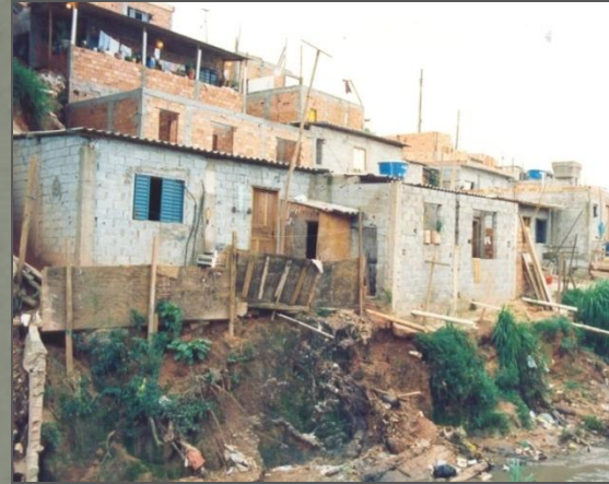
Figura 02 – Área de Risco. Cd.apoio.
