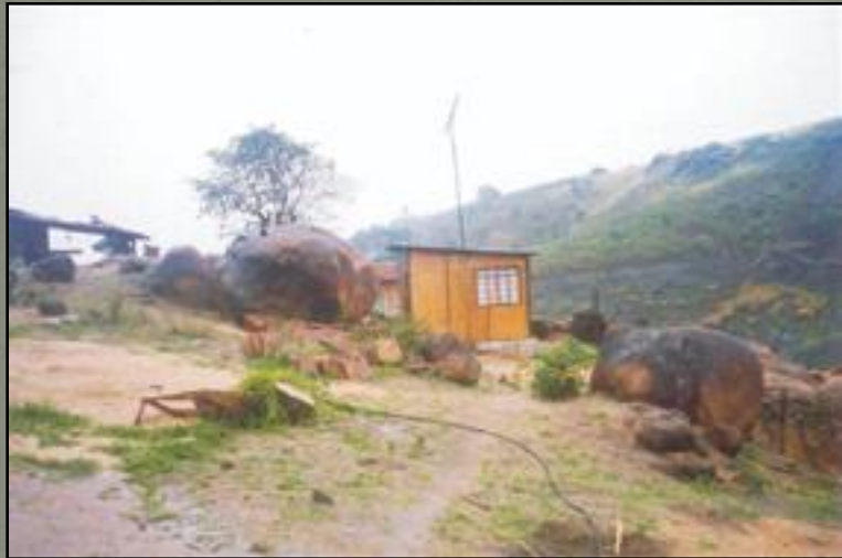
Figura 18 - Situação de risco de rolamento de bloco rochoso.p.37.
