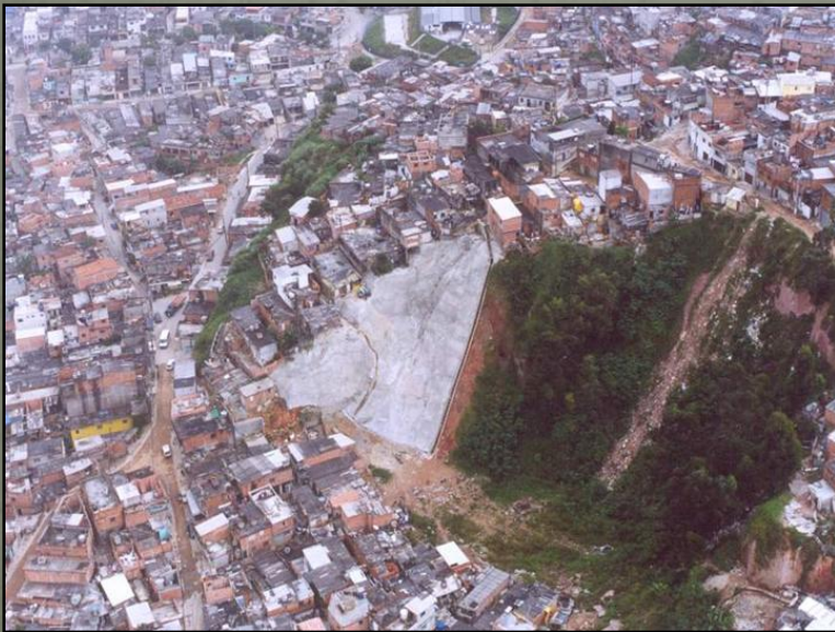
Figura 05 – Áreas de Riscos. Cd.apoio.
