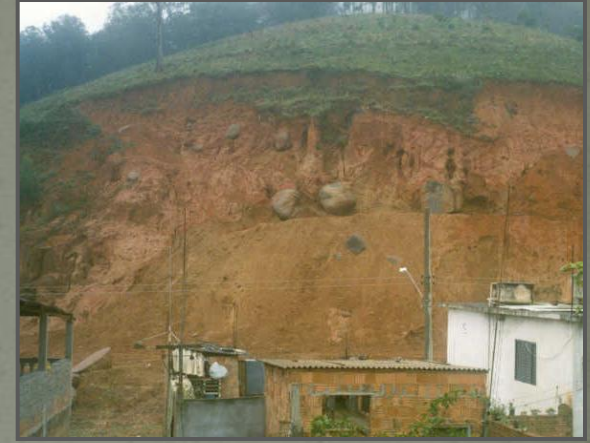
Figura 03 – Área de Risco. Cd.apoio.
