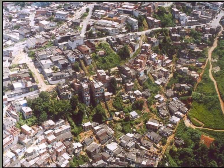
Figura 06 –Áreas de Riscos.Cd.apoio.
