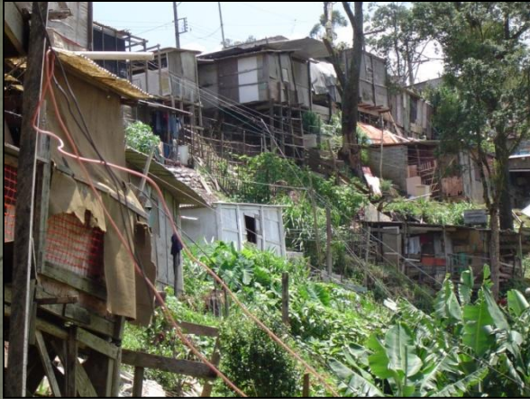
Figura 01 – Área de Risco. Cd.apoio.
