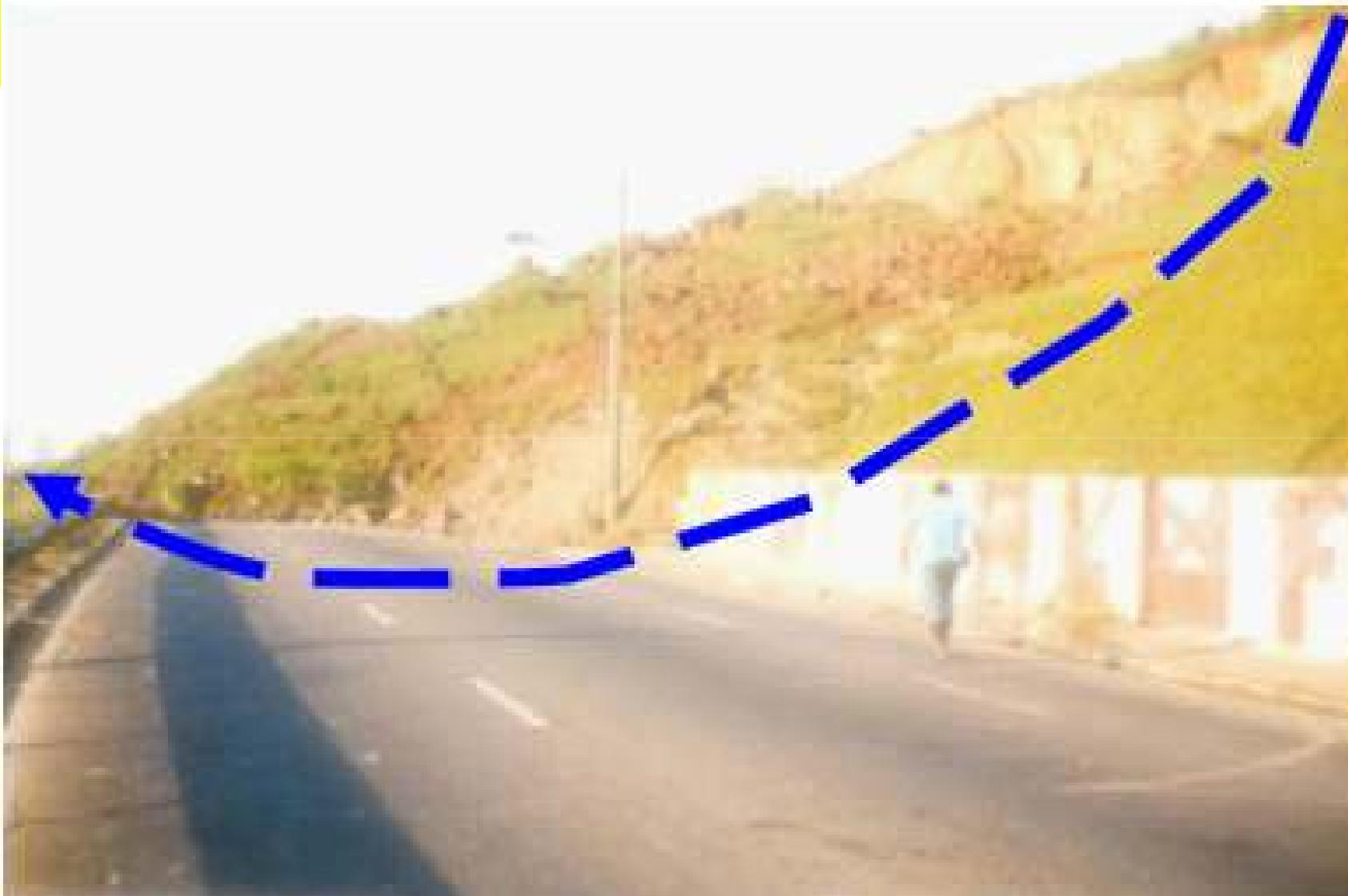
Fig. 12 – Escorregamento circular ou rotacional
