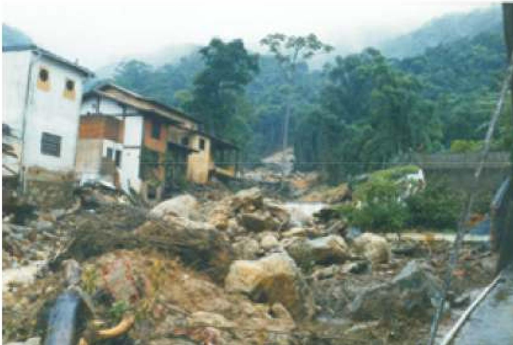
Fig. 19 Acidente associado ao processo do tipo corrida
