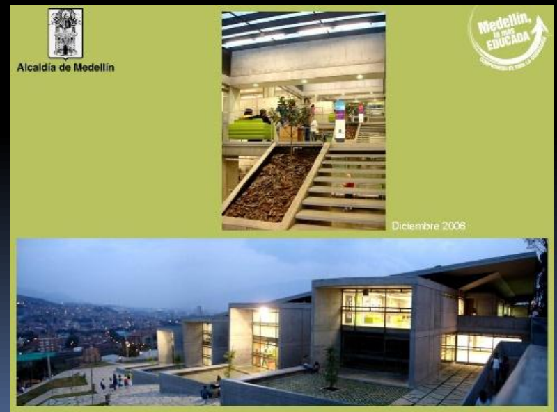
Imagem 21: http://urbanismosocialmedellin.universia.net.co Parque Biblioteca Presbítero José Luis Arroyave – San Javier – Zona Centro Oeste
