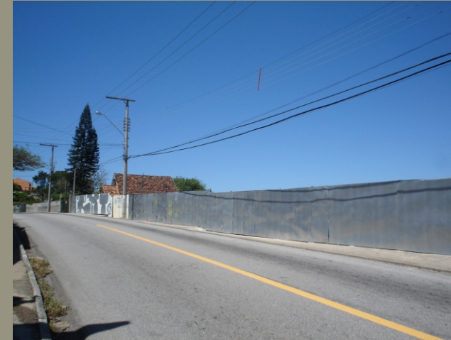
MUROS AO LONGO DA VIA IMPEDEM VISIBILIDADE
