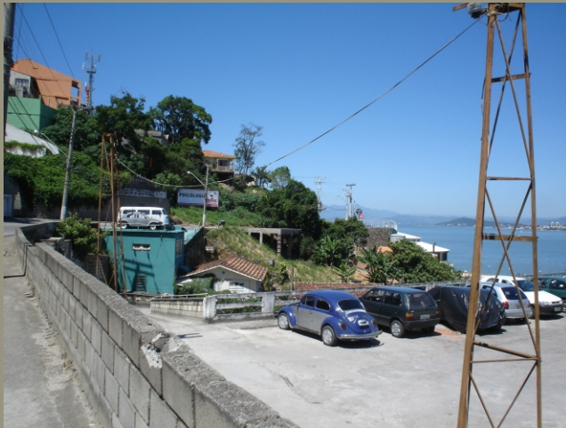
MUROS E DEGRADAÇÃO DAS MELHORES VISTAS
