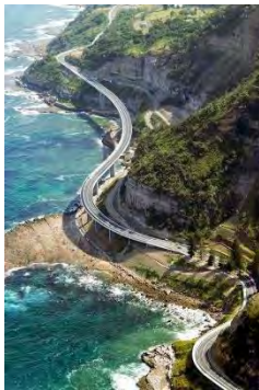
Figura 190: Vista superior Sea Cliff Bridge na Great Ocean Road . A estrada apoia pista em alguns pontos da encosta onde o relevo favorece. No restante sobre estrutura de pilotis. Fonte: Pinterest, 2014.
