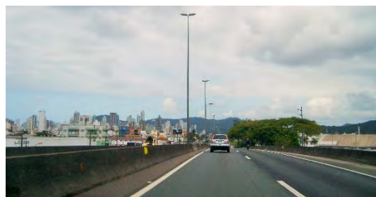
Figura 319: 2 – Deslocamento norte-sul. BR-101 entre Balneário Camboriú e Camboriú.
