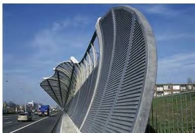
Figura 44: Barreira acústica também gera energia a partir de placas fotovoltaicas. A16 próxima de Dordrecht , Holanda.
