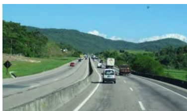
Figura 414: Divisão de pistas por blocos de concreto, barreira tipo New Jersey no município de Biguaçu, BR-101/SC Fonte: Angela Favaretto, 2012.
