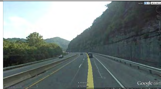
Figura 119: 1 - Estrada desenvolve-se na planície aluvial entre o morro e o rio. Utilizam barreiras nas laterais da encosta em acive onde foi cortada para acomodar a estrada. Entorno natural.
