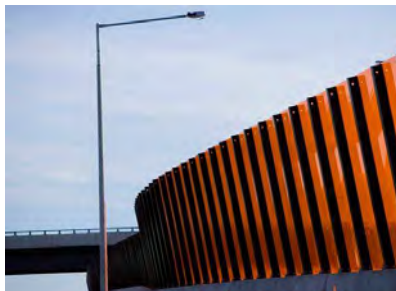
Figura 43: Barreira acústica compoondo paisagem. Melbourne, Austrália.
