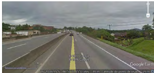
Figura 292: BR-101/SC em área urbana de Joinville, sobre viaduto que faz a continuação de um rua urbana que está em nível inferior que a BR-101.
