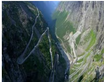
Figura 38: Estrada em montanha, Trollstigen, Noruega.
