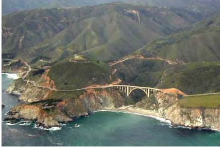
Figura 86: Estrada cênica Route 1 na Califórnia. Via panorâmica costeira. Grande parte do traçado desenvolve-se na encosta. Considerada All-American Road (US, 2016). Na imagem a Ponte Bixby, entre as cidades de Carmel e Big Sur. Fonte: Neilson, 2001.
