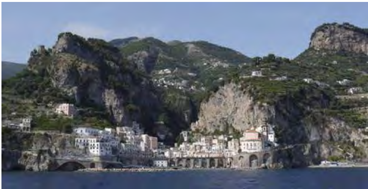
Figura 39: Costa de Amalfi, Itália. Vista para a cidade de Amalfi. Em arcos está apoiada a estrada SS163. Nota-se os edifícios escalonados, acomodando-se na encosta, assim como a agricultura nos terraços.
