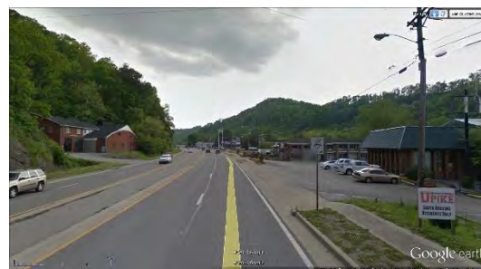
Figura 121: 2 - Área urbanizada, uso predominantemente de serviço. A estrada adota desenho diferente do que quando passa em área não urbanizada, suprimindo barreira central, adicionando calçada e acesso ao pátio frontal das edificações.
