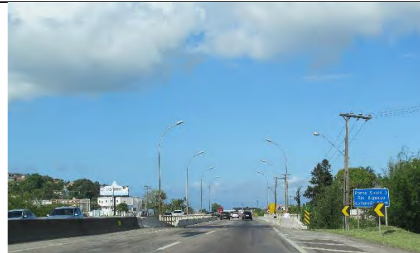
Figura 359: 1 – BR-101/SC, ponte sobre rio Biguaçu. Olhando em planta, nota-se bastante proximidade com o mar, mas não há visão para o mar pela curva vertical do traçado, que direciona a visão para cima, enquanto o mar está para baixo. Fonte: Angela Favaretto, 2012.
