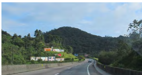
Figura 421: Chegada ao túnel, divisa Itapema e Balneário Camboriú. Área com caráter natural. Excesso de publicidade polui a paisagem. Situação atual.
