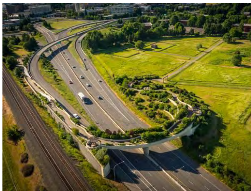
Figura 41: Passagem de pedestres no formato de praça elevada sobre a rodovia e a linha de trem. Vancouver, Canadá. Fonte: LAN, 2014.
