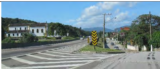
Figura 351: 1 - BR-101/SC trecho norte na frente do Conjunto Arquitetônico de São Miguel. Saída para via marginal que dá acesso às edificações e ao viaduto para transpor a rodovia e possibilitar retorno. A rodovia passa muito próximo do patrimônio histórico, colocando-o em situação de vulnerabilidade. Fonte: Angela Favaretto, 2012.
