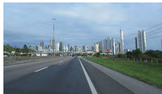
Figura 320: 3 - Deslocamento sul-norte logo após o túnel.
