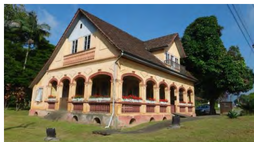
Figura 289: Casa Krüger. Vista da estrada Dona Francisca. Fonte: Rosa, 2016.
