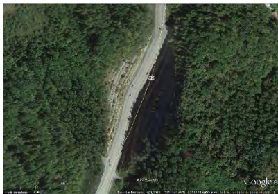
Figura 129: Imagem aérea da Country Music Highway em Jenkins. Destaque para retaludamento da encosta.
