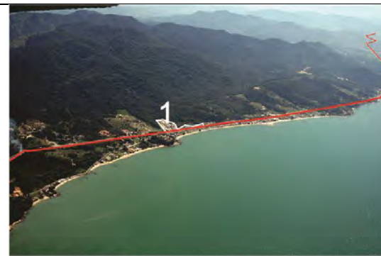
BR-101 1. Conjunto arquitetônico tombado IPHAN
