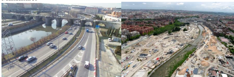
Figuras 8 e 9: Madri com a M-30 e em obras para o projeto parque rio Manzanares
