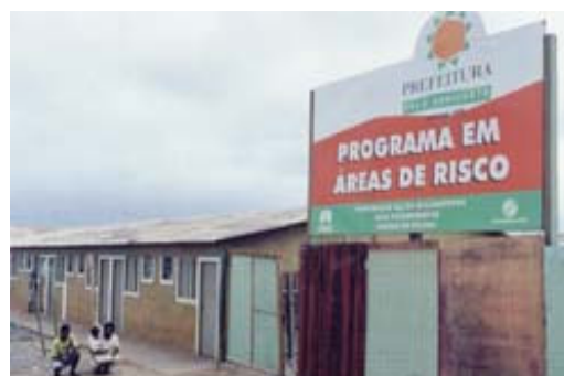
FOTO 6: Programa em Áreas de Risco, Belo Horizonte. Fonte: PBH - URBEL, mar. 2000.
