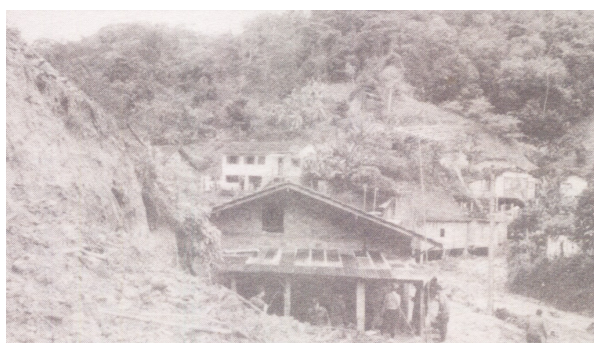
Trabalhos de recuperação lentos Fonte: Cleide de Oliveira, DC, 1990
