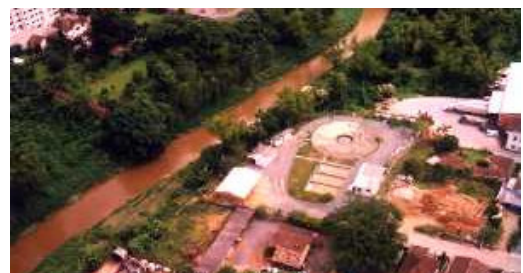
FOTO 11: Estação de Tratamento Esgoto – ETE. Fonte: SAMAE, 2005.
