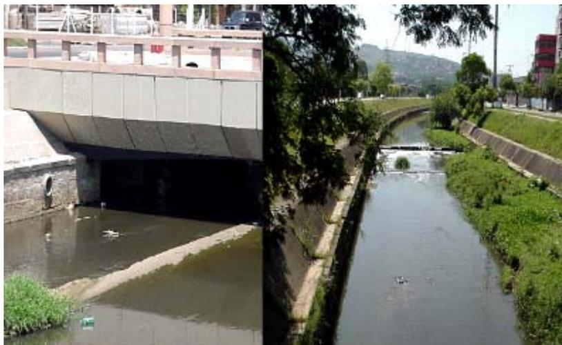
Figura 19: Exemplo de canalizações que aceleram processo de escoamento (Silveira, 1999)
