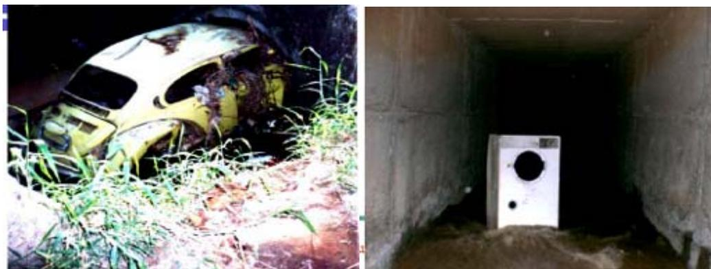
Figura 22: Obstrução da drenagem devido à deposição de lixo nos canais pela população (Tucci, 2002)
