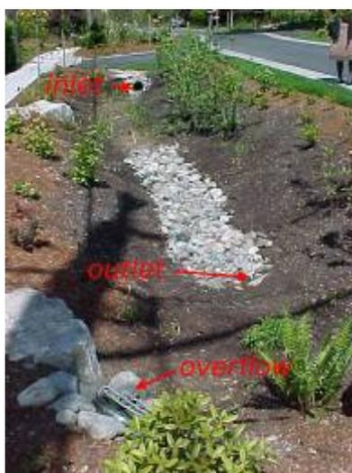
Figura 40: Planos de infiltração com valo de infiltração (IPH, 2000)
