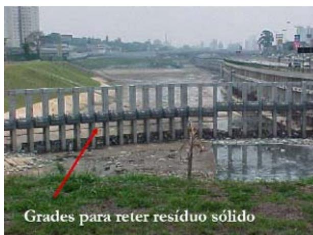
Figura 52: Área de detenção com barreira para resíduos sólidos (Campana et al, 2001)
