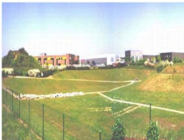
Figura 49: Área de parque com tratamento paisagístico na França destinada à retenção das águas pluviais (Campana, 1995)
