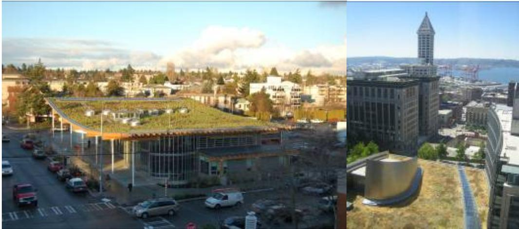
Figura 46: Coberturas permeáveis com retenção de águas no lote (Cormier, 2006)
