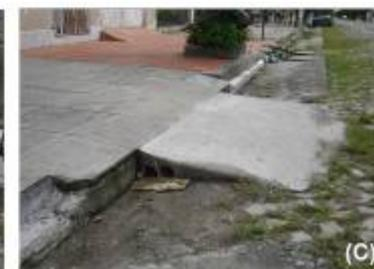
Importância da microdrenagem nas áreas baixas: (a) preocupação de evitar entupimentos dos dutos; (b)(c) soluções de rampas que dificultam escoamento pluvial provocando acúmulo de água em áreas baixas
