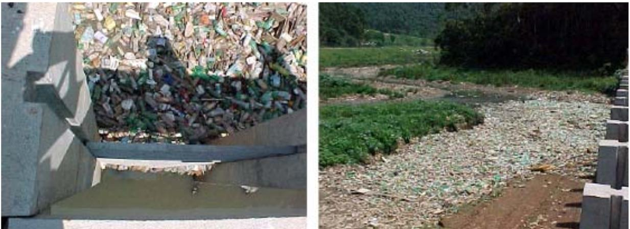
Figura 24: Embalagens plásticas que obstruem o escoamento das águas nos canais de drenagem (Tucci, 2002)
