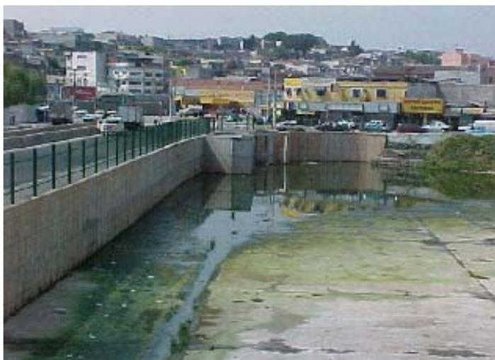
Figura 55: Reservatório de concreto para detenção em São Paulo/SP (Campana et al, 2001)
