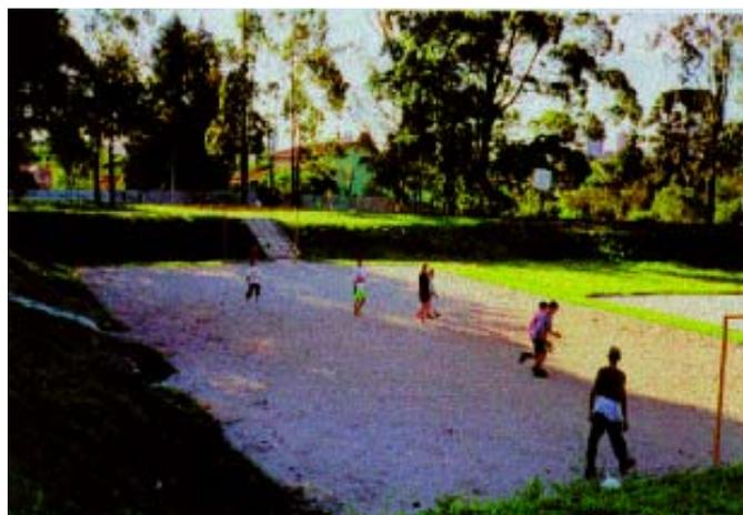
Figura 54: Reservatório de retenção usado para prática de esportes em Porto Alegre/RS (Tucci, 2001)
