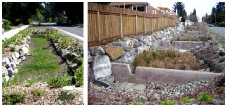
Figura 42: Valos de infiltração com elementos para barrar poluição com resíduos (IPH, 2000)
