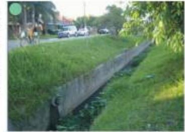
Demonstração de uma das poucas soluções verificadas no sistema de macrodrenagem da zona urbana, onde percebe-se a intenção de um tratamento paisagístico onde foram resguardadas as margens evitando-se a ocupação do leito do canal. A estrada à esquerda da imagem corresponde ao dique de proteção que acompanha o traçado do Canal Santa Bárbara.
