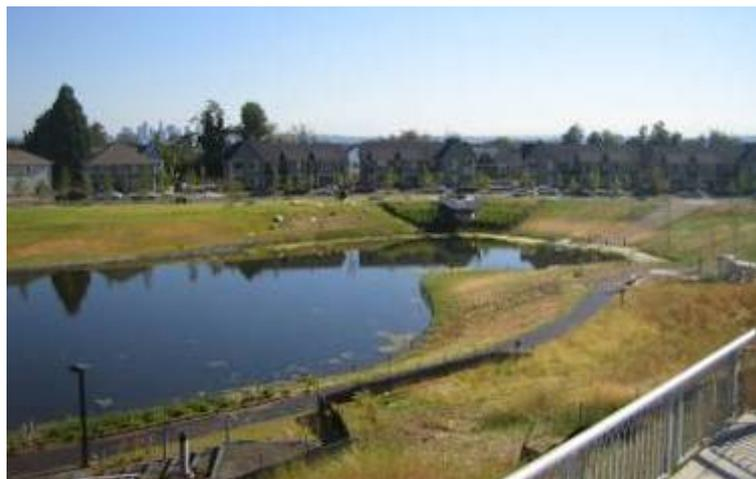
Figura 51: Área destinada à detenção das águas pluviais com tratamento de parque urbano (Cormier, 2006)
