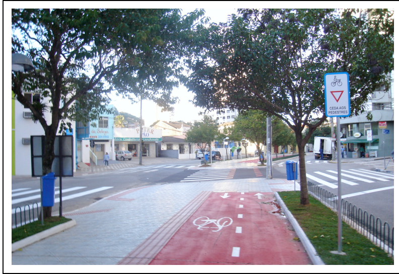
Figura 35: Sinalização ao longo do trecho Avenida Hercílio Luz (acervo do autor)
