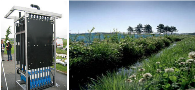
Figura 7 - Tratamento Terciário: Membranas (esq.) e Jardins Filtrantes (dir.).
