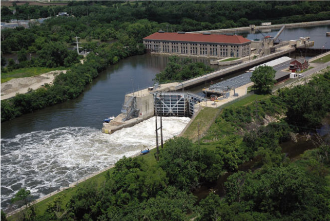
Figura 35 - Contenção de águas pluviais, Chicago.
