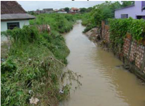
Figura 49 - Ocupações nas margens do Rio Serraria (afluente do Rio Maruim). Área constantemente atingida pelas enchentes.
