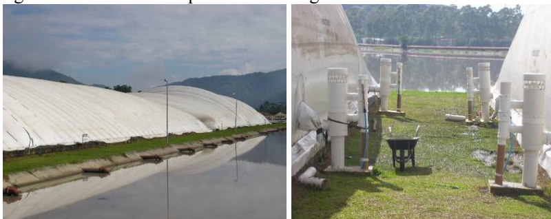
Figura 66 - Reator com queimadores de gás.
