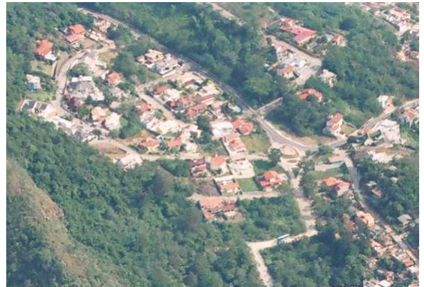
Figura 24: Impacto na paisagem devido à alta densidade de edificações no Loteamento Morumbi. Fonte: Defesa Civil, 2006.
