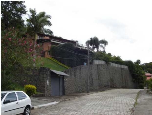
Figura 23: Loteamento Morumbi e muros de contenção de elevada altura para viabilizar traçado viário. Fonte: Marlon Pscheidt, 2006.
