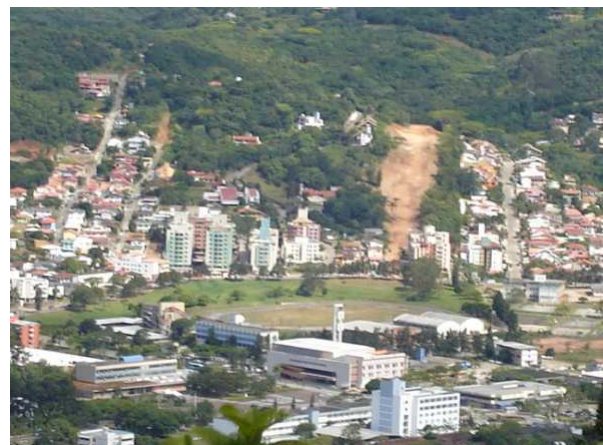
Figura 5: Problemas de erosão afetam edificações vizinhas devido a solo de alteração exposto. Fonte: Marlon Pscheidt, 2005.
