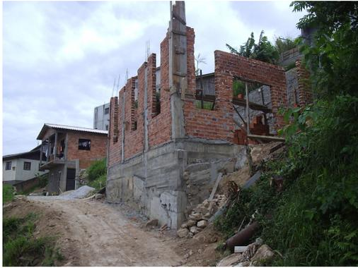
Figura 9. Construção em alvenaria e com aterro. Fonte: autor, 2005
