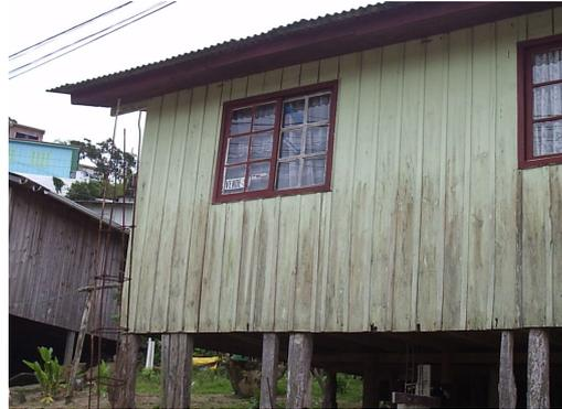
Figura 10: Construção em madeira fazendo o uso de pilotis. Fonte: autor, 2005
