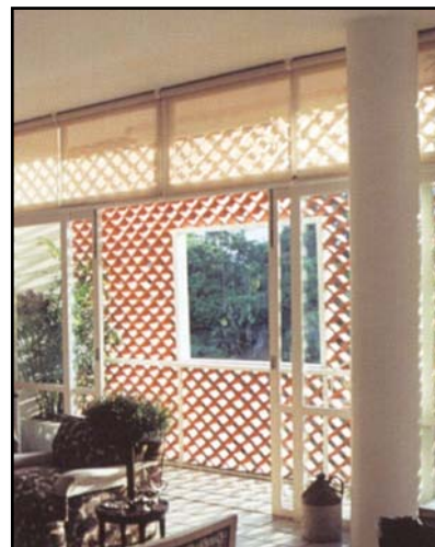
Foto 12 – Elementos de vedação que protegem da insolação, sem tirar o visual. Fonte: Wisnik. 2001
