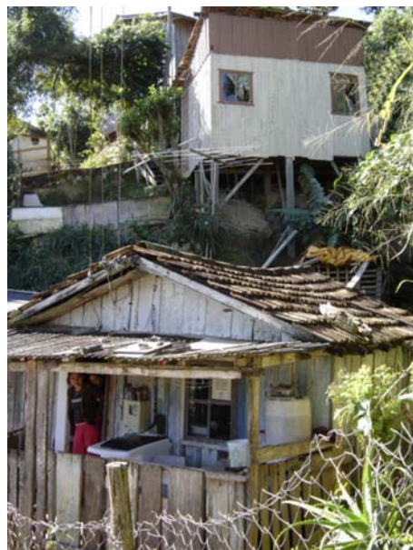
Foto 03: Implantação de casa com possível situação de risco Foto: Priscilla Mandaji
