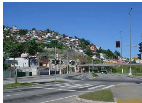
Foto 18: Túnel de ligação Centro-Sul da cidade Foto: Priscilla Mandaji
