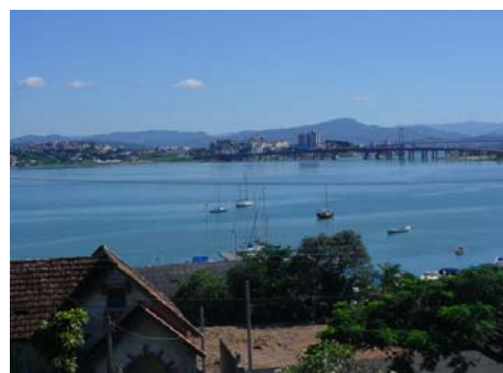
Foto 07: Vista da Ponte Hercílio Luz a partir do Bairro da Prainha
