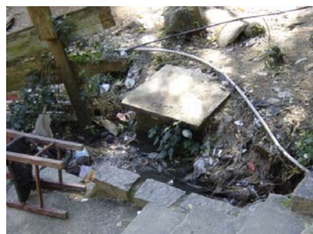
Foto 20: Esgoto e lixo a céu aberto Foto: Priscilla Mandaji
