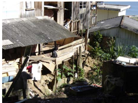
Foto 10: Residência no Morro do Mocotó construída com restos de materiais Foto: Priscilla Mandaji
