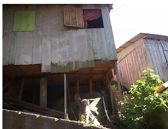
Fig. 9. Moradia apoiada em pedra. Morro da Queimada. Fonte: autor, 2005.
