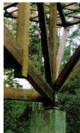
Figura 16 – Junção dos elementos estruturais. ACAYABA (2010)
