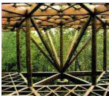
Figura 17 e 18 - Montagem da grelha e estrutura da cobertura em madeira. ACAYABA (2010)
