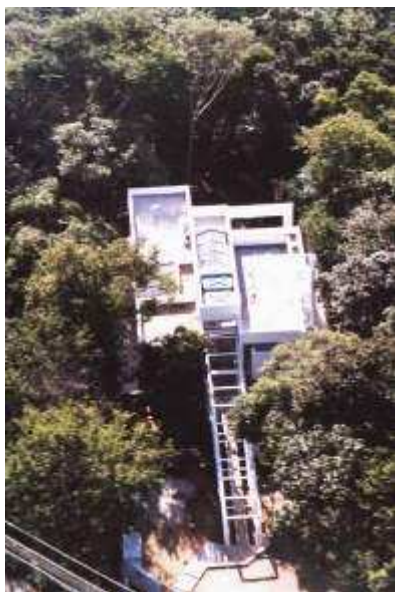
Figura 24 - Imagem aérea da residência Canto da Lagoa. BONETTI (2000)
