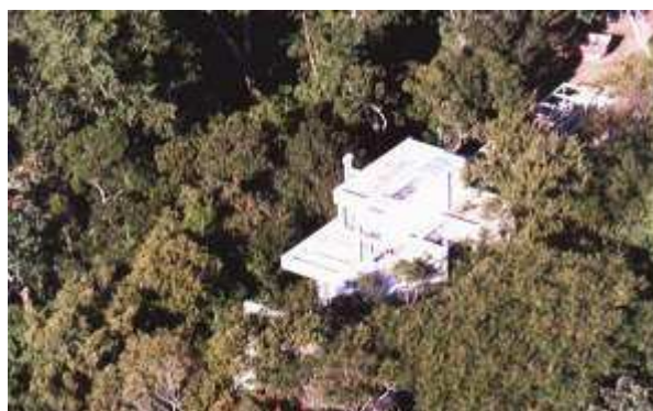
Figura 25 - Imagem aérea da residência Canto da Lagoa. BONETTI (2000)
