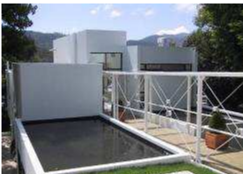
Figura 40 – Passarela metálica e espelho d'água no acesso à residência. BONETTI (2000)
