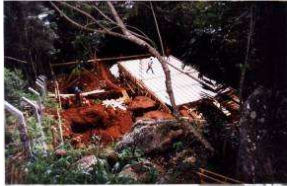
Figura 32 – escavação de terra para as fundações. BONETTI (2000)
