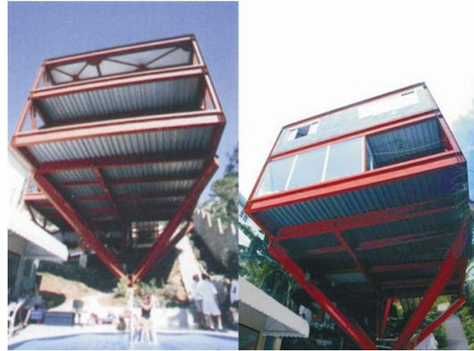
**Figura 38:** Estrutura de aço com poucos pontos de apoio no solo. FONTE: Leonor Hartmann.
