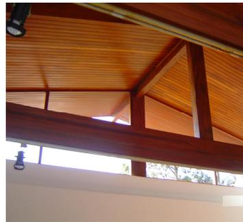
**Figura 34:** Estrutura do telhado em madeira. Acervo pessoal.
