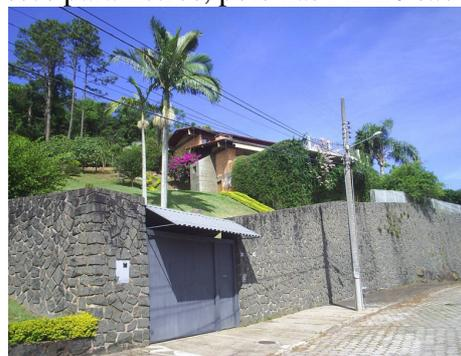
**Figura 28:** muro de contenção para a implantação do sistema viário. Acervo pessoal.
