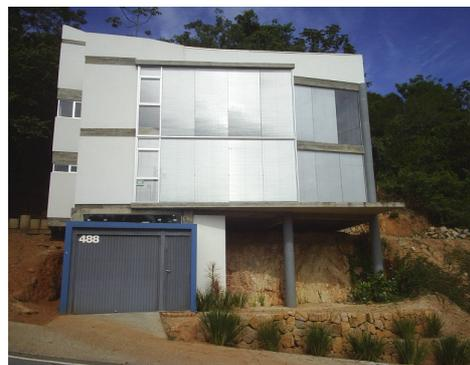
**Figura 27:** Residência implantada com a realização de cortes no terreno. Acervo pessoal.
