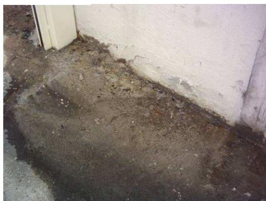
Figura 7 - Infiltração junto à entrada de veículos muro de contenção na quadra
