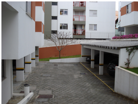
Figura 10 – O uso de pilotis na garagem.
