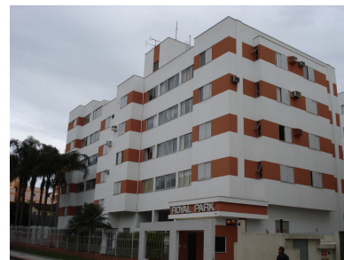
Figura 2 - Edifício Royal Park.
