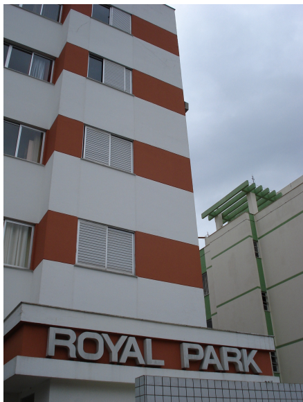
Figura 19 – aberturas com persianas e outras apenas em vidro.
