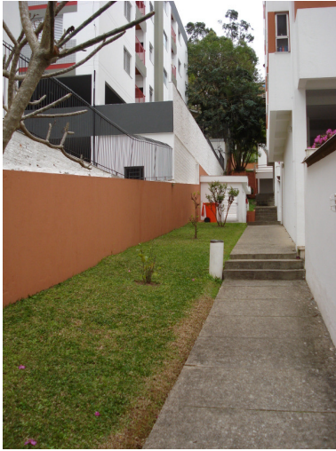
Figura 13 – Circulação destinada aos pedestres.
