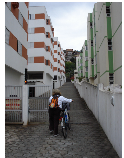
Figura 14 – Mesma circulação de pedestres e veículos.
