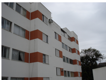
Figura 18 – esquadrias em alumínio e vidro.
