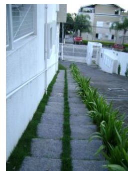
Figura 17: Acesso pedestres e veículos, escadaria e rampa respectivamente. Fonte: Autora, 2009
