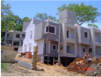
Figura 15: Movimentação de terra durante a construção. Fonte: Sonia Afonso, 2005.
