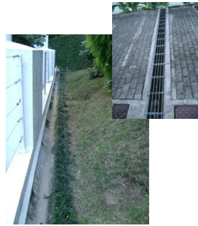
Figura 13: Drenagem superficial, canaletas moldadas in loco. Fonte: Autora, 2009.
