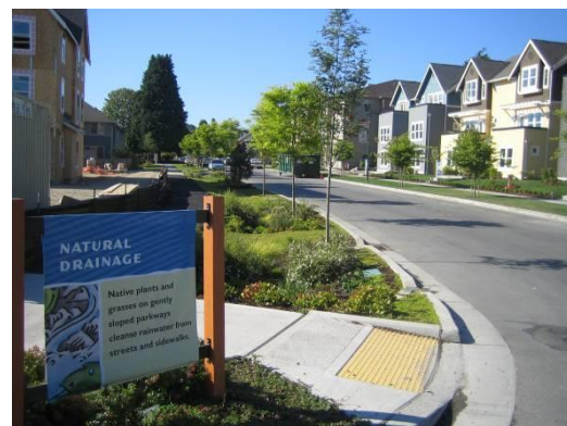
Figura 13: Biovaleta em High Point Fonte: CORMIER, 2006
