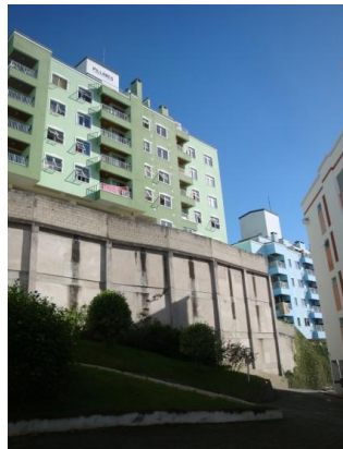
Figura 21: Residencial Belvedere relação entre muro e edificação vizinha – Residencial Itália. FONTE: Fotos Lis M. Cavalcante, 2010.
