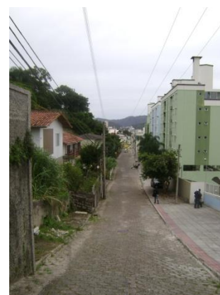
Figura 35: Interrupção do passeio e rua atravessando drenagem principal – Rua José João Martendal. Fonte: MICHELETI, 2010.
