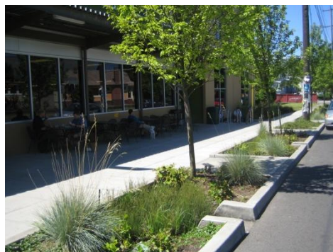
Figura 2: Canteiro pluvial em Portland, Oregon, EUA. FONTE: CORMIER, 2006.
